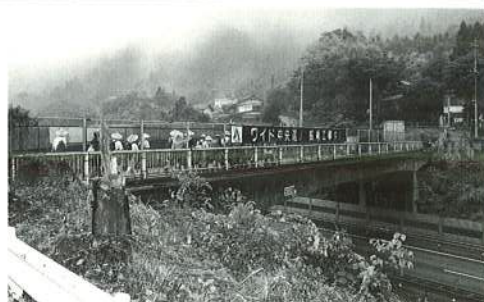
【中央道に架かる矢坪橋】
